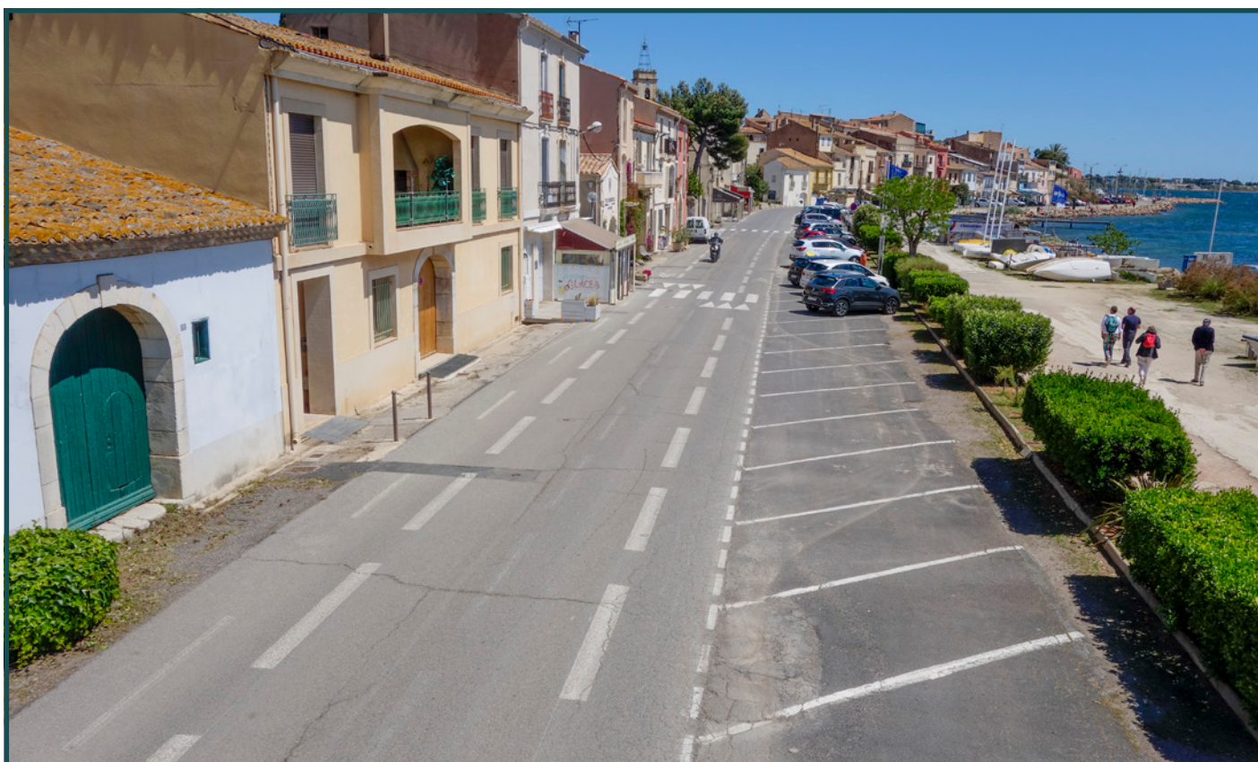
Chaussée à voie centrale banalisée
