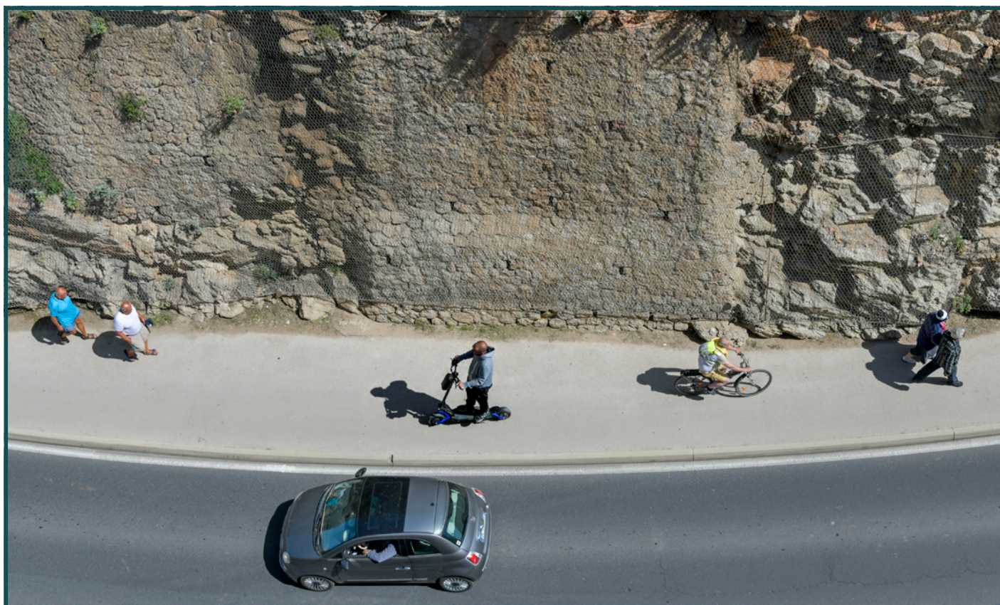
Exemple d'un trottoir partagé-promenade du Maréchal Leclerc à Sète
