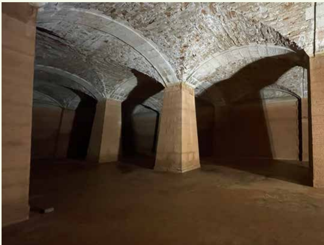
Ci-contre, le réservoir d'eau de Sète.
