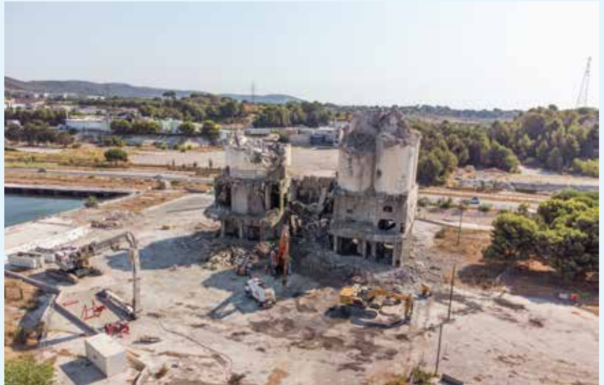
Travaux de destruction du site Lafarge
