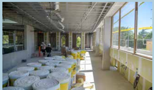
Ci-dessous la construction de la médiathèque intercommunale de Balaruc
