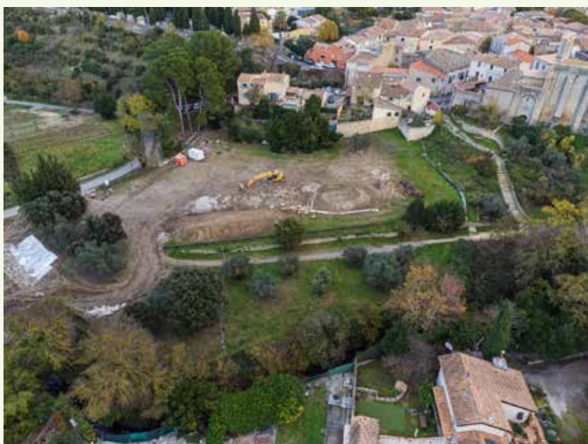
Travaux sur les berges de la Vène à Montbazin
