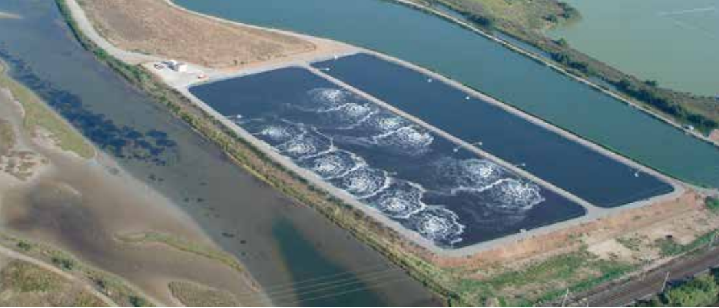
Le lagunage pour épurer les eaux
