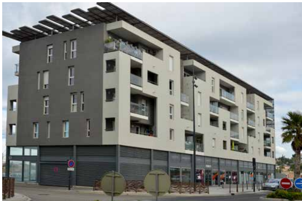
Ci-dessus : résidence Les Thocs, quartier du Villeroy, à Sète
