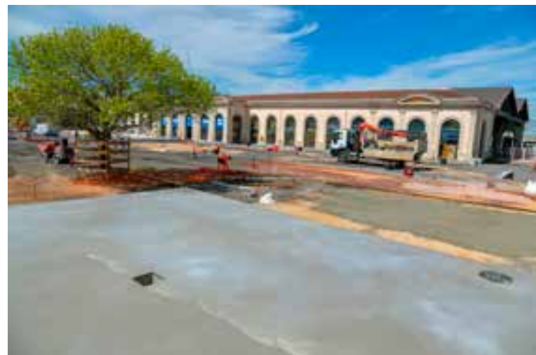
Derniers aménagements pour le parvis SUD du pôle d'échange multimodal (PEM) de la gare de Sète avant son ouverture prévue mi-juillet.
