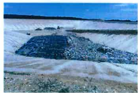
Casier sud, les 1 er dépôts, pose de filets anti-envol à l'ISDND de Villeveyrac
