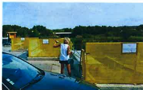
Rénovation des garde-corps sur les déchetteries
