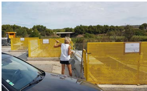
Rénovation des garde-corps sur les déchetteries
