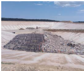
Pose de filets périphériques à l'ISDND
