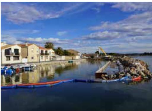
La Ville de Mèze a lancé un important chantier de rénovation du quai du port des Nacelles. Une partie importante du quai avait, en effet, subi une dégradation due à une forte érosion à sa base, elle-même provoquée par le courant. Le front de quai abîmé a été totalement démoli pour la réalisation d'un nouvel appontement avec la mise en place de murs de soutènement. Les travaux sont réalisés en milieu maritime dans le respect strict des spécifications réglementaires en matière de
