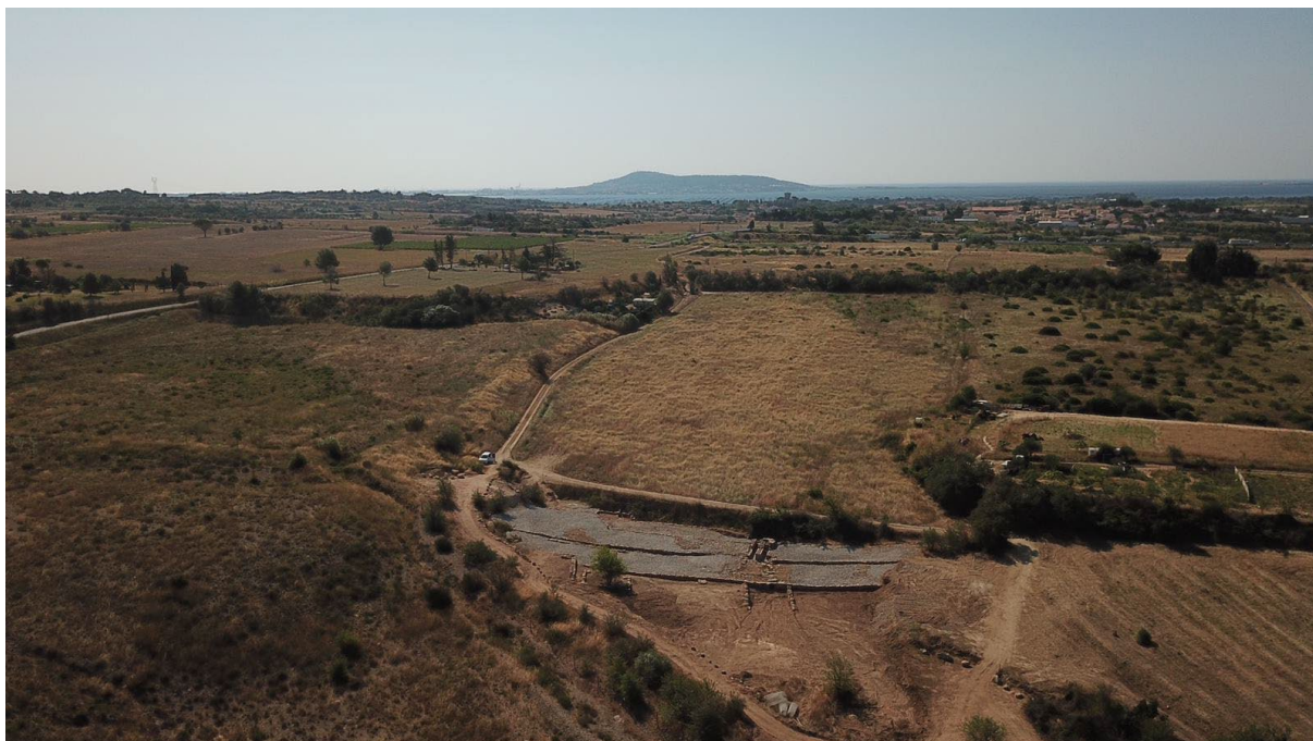
Vue de drone du chantier valorisé (Cliché : R. Campillo)
