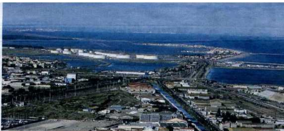
Le périmètre de ce nouveau quartier comprend des zones classées inondables. PHOTO PHILIPPE ARNAUD
