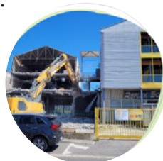
Chantier des 3 sommets avec dépose préservante et réemploi
